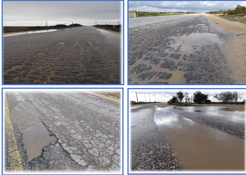
شكل 3. صور توضيحية للأضرار من شقوق شبكية وتمساحية على طريق بوذراع – القبة
